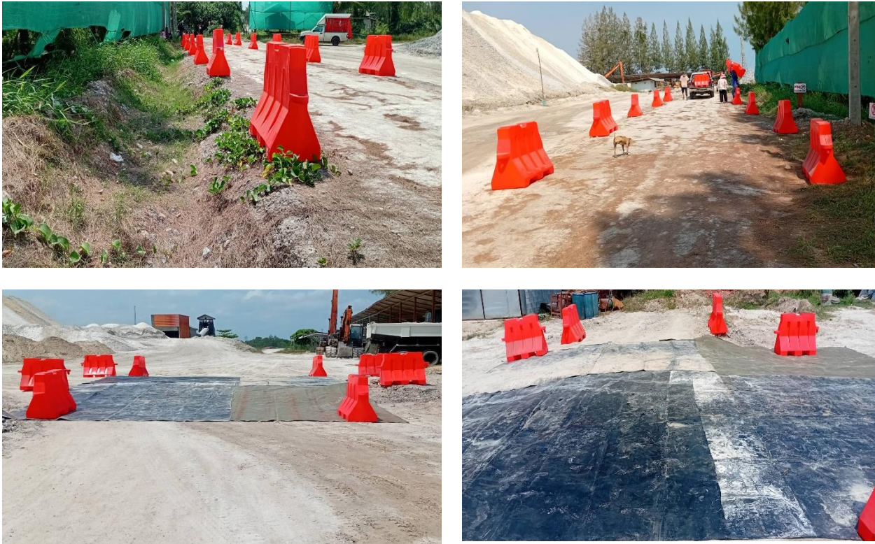
รูปที่ 4.3.2-2 การติดตั้งแบรีเออร์กำหนดแนวเขตเส้นทางสาธารณประโยชน์ระหว่างแปลงที่ดินของโครงการ
